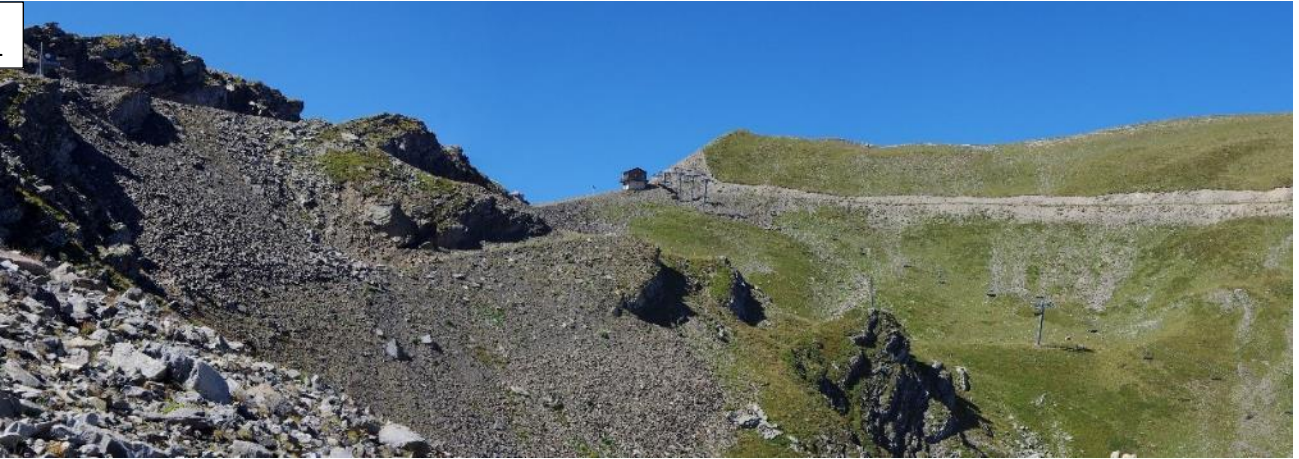
VUE SUR L'ARRIVEE DU TELESIEGE DES CHAUDANNES
