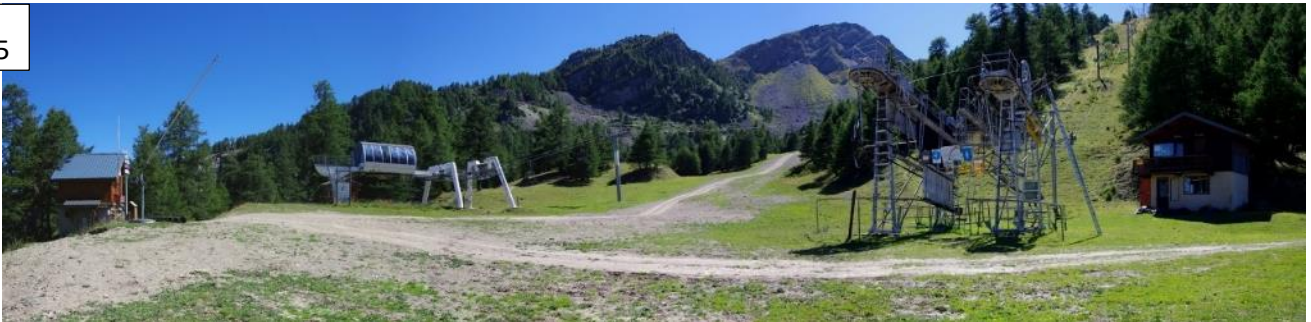
VUE D'ENSEMBLE DES GARES D'ARRIVEE DE CHAUDANNES ET DES TELESKIS DE LA TETE D'ALBIEZ
