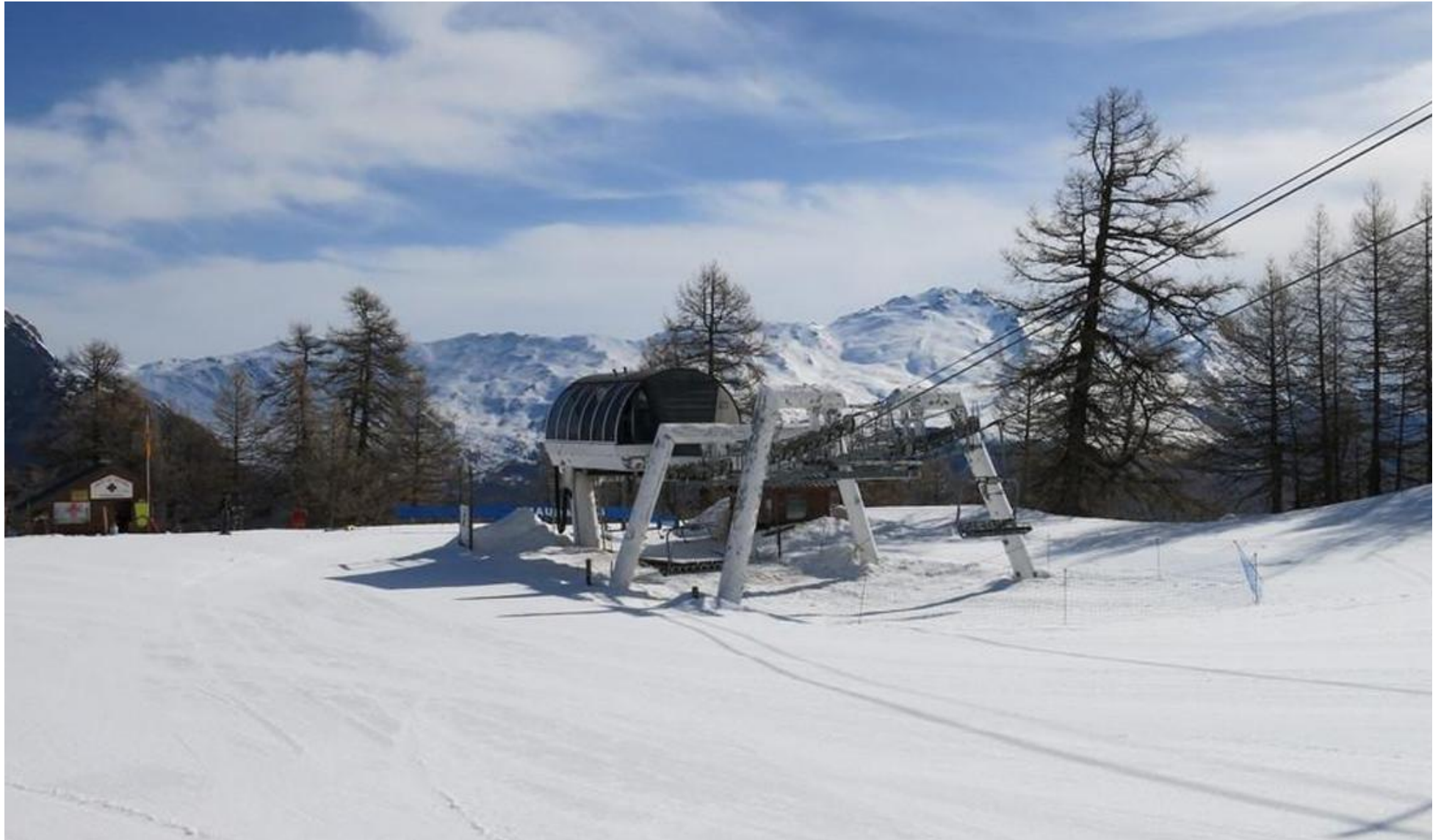
INSERTIONS PAYSAGERES GARE AVAL - VUES EXISTANTE - TSF CHAUDANNES – SOURCE : E.R.I.C
