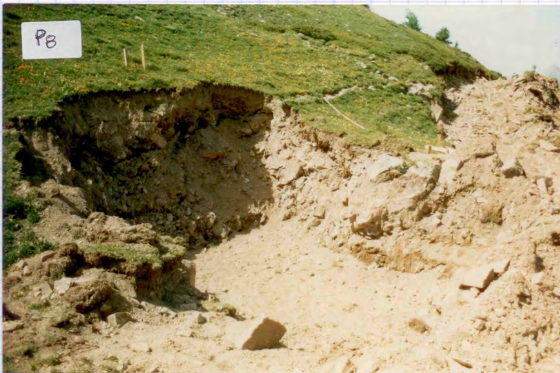
Horainc aeri + blocs rocheux ebrulis sans remarque.
