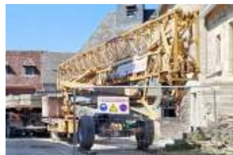
Le démontage de la grue marque l'avancement des travaux dans le bourg.
