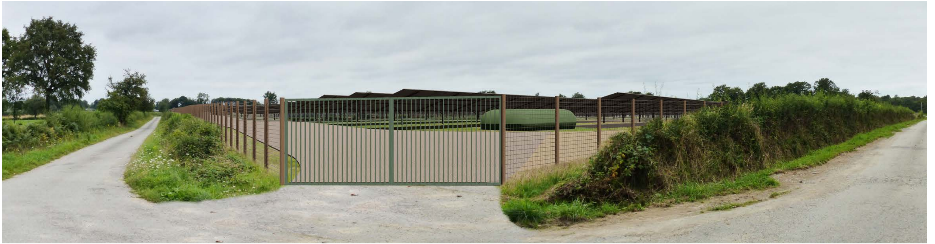
Point de vue n°8 - Vue depuis la voie existante au croisement des îlots n°6/5/3 donnant sur le nord-est de l'îlot n°3
