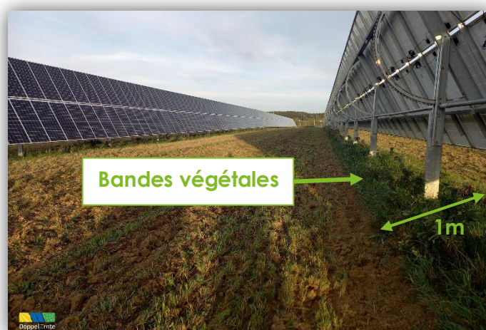
Figure 33 : Bandes végétales aux pieds des pieux, d'une largeur d'un mètre de part et d'autre
