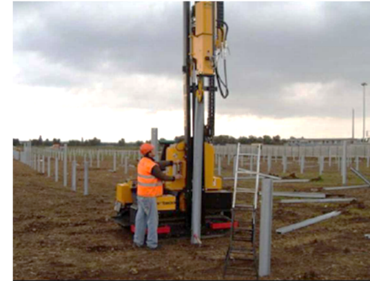
Fig.5 Exemple de pieu battu (source ENGIE)
