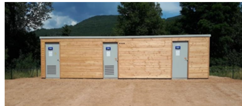
Fig.14 Exemple de poste de livraison
