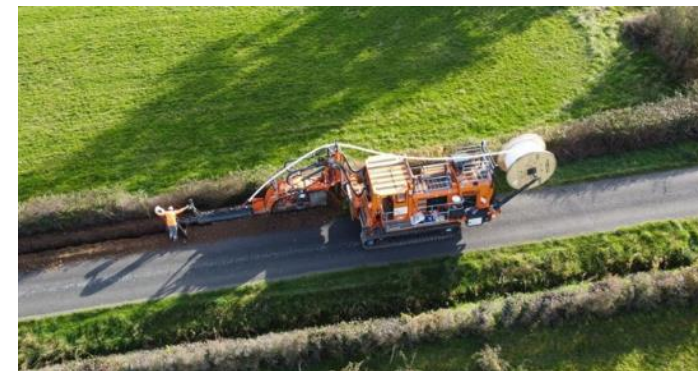
Fig.17 Pose des lignes souterraines - crédit photo CEGELEC
