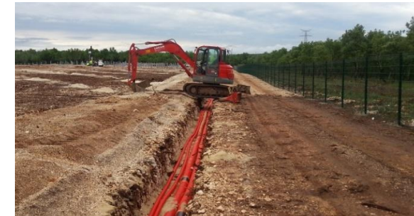
Fig.29 Exemple de réalisation de tranchées électriques (Source : ECO-STRATEGIE)
