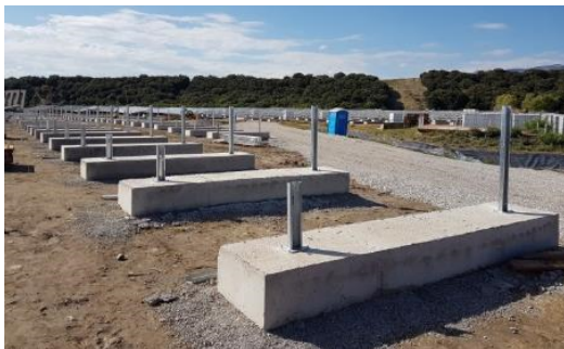
Fig.7 Exemple de fondation en béton
