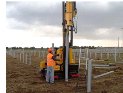
Fig.8 Exemple de pieu battu (source ENGIE)
