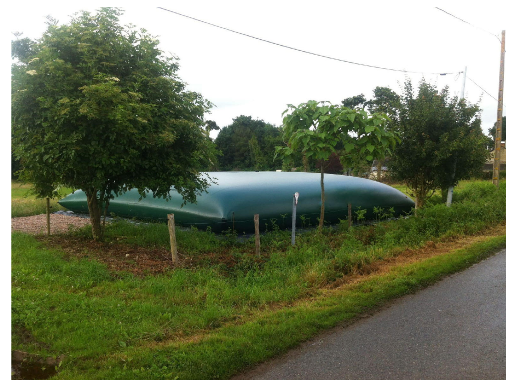
Réserve incendie en citerne souple Photographie d'illustration
