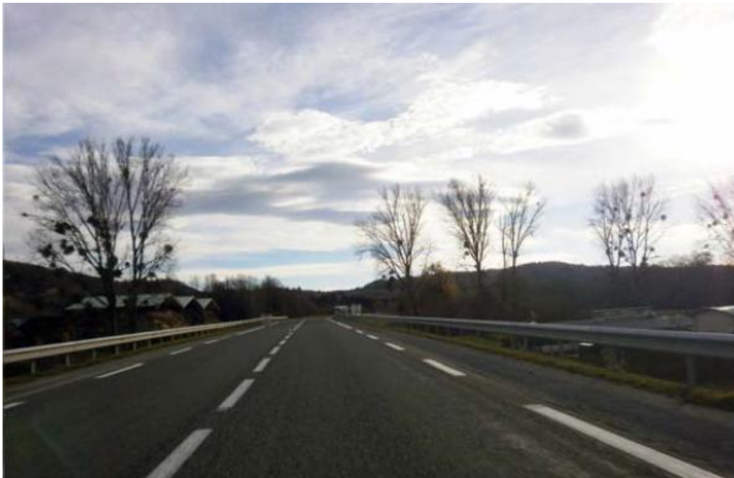
Figure 6 : Vue depuis le Nord de la RD 470 - la ZIP est du côté droit de la route (PLU Moirans-en-Montagne)
