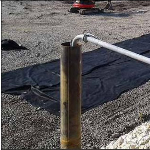
Figure 9 : Illustration d'un puit crépiné de rabattement
