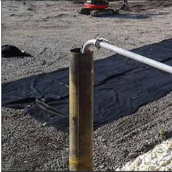
Figure 9 : Illustration d'un puit crépiné de rabattement
