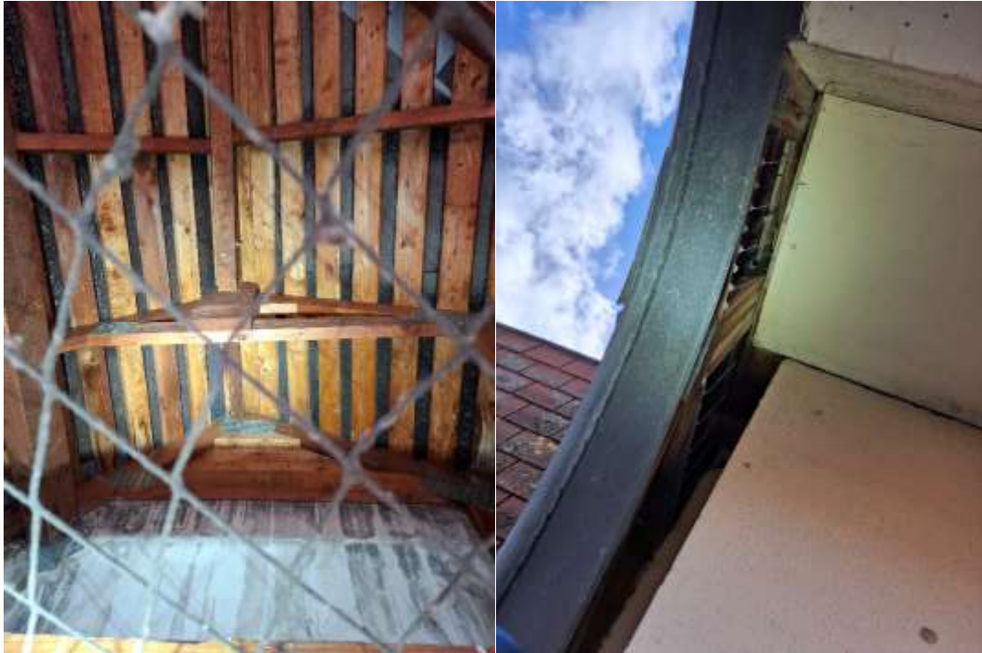
Figure 38 : Espaces potentiellement favorables aux gîtes des chiroptères sous les zones abritées des toitures des bâtiments de la zone d'étude
