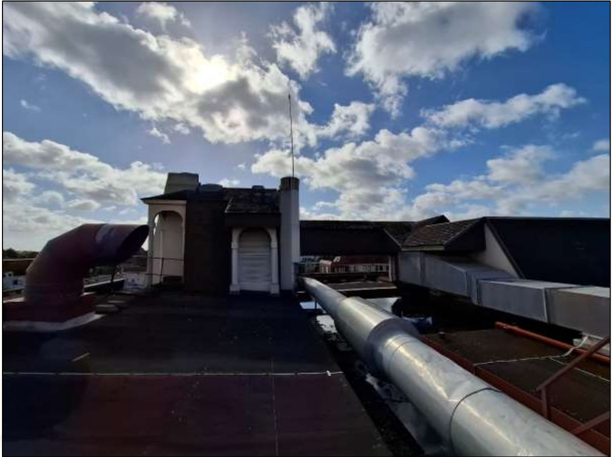
Figure 37 : Exemple de zone abritée sur les toitures des bâtiments de la zone d'étude
