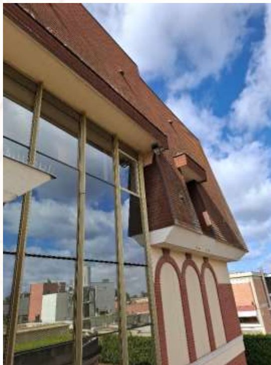
Figure 39 : Absence d'espace favorable aux gîtes des chiroptères entre la toiture et la façade extérieure
