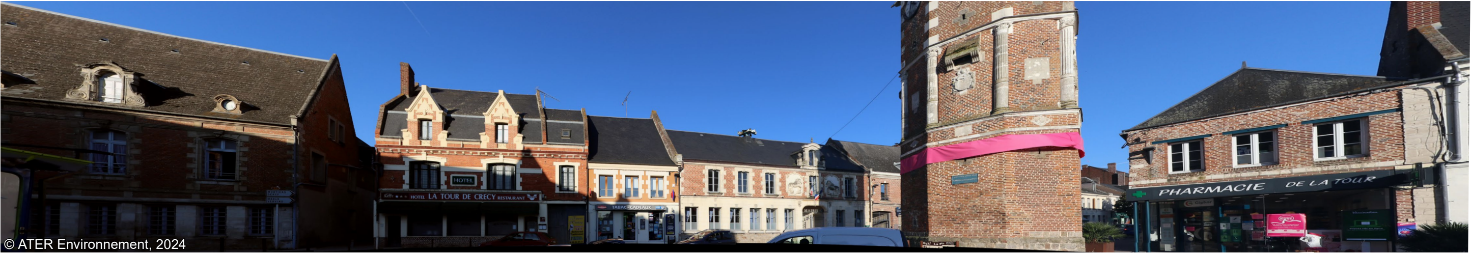
Fig. 53 : Hôtel de ville et Beffroi de Crécy-sur-Serre - Partiellement inscrit (ouest de l'AEE)
