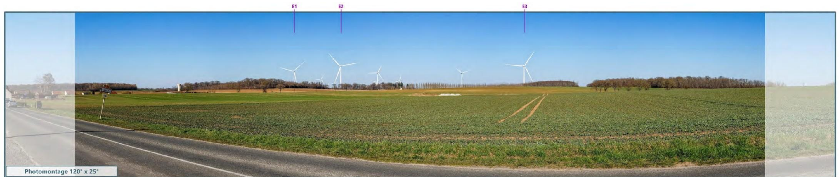
Photographie 5 : PM n°37 Vue depuis la sortie sud-est de Liez au niveau de la D53 © ATER environnement
