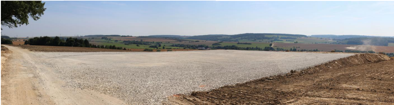
Photo 2 : Plateforme de montage d'éolienne (Source : Ora environnement)
