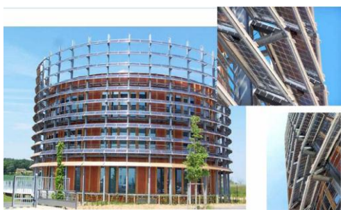
Brise soleil considéré comme intégré au bâtiment
