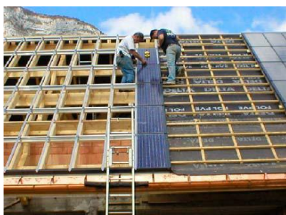
Toitures considérées comme intégrées au bâtiment
