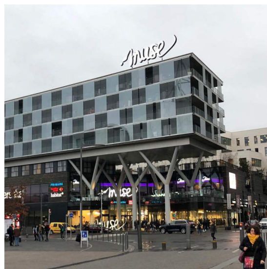
Figure 17: Entrée nord du MUSE
