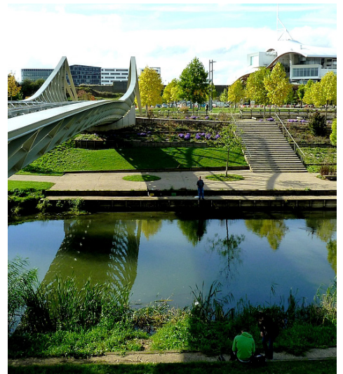
Figure 21: La Seille traversée par la passerelle du Graoully
