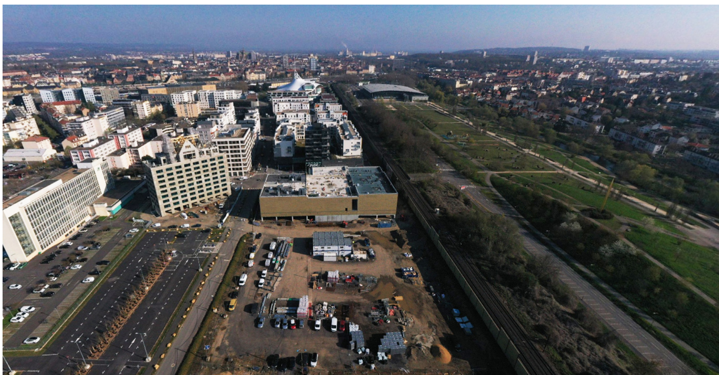
Figure 31: Capture Drone vers le Nord, ZAC partie 1 et Centre-ville de Metz, 2022
