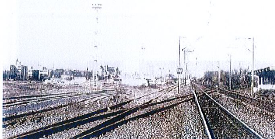
Le site de l'ancienne gare de marchandises
