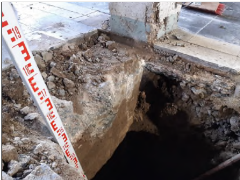
Photo 4 : la reconnaissance de fondation RF2 à l'intérieur du bâtiment
