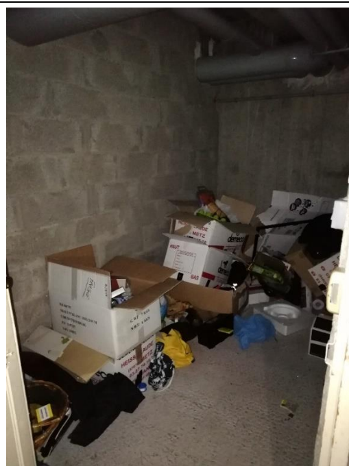
Vue de l'intérieur des caves (en sous-sol) du bâtiment des officiers
