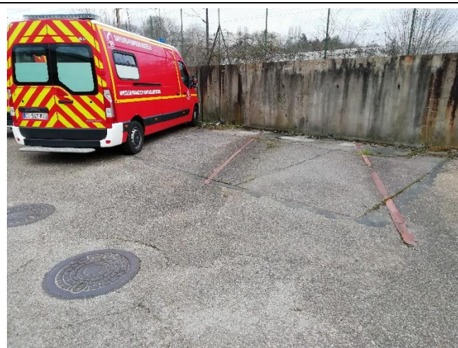
Vue de l'emplacement de l'ancienne station carburant à l'Ouest du site
