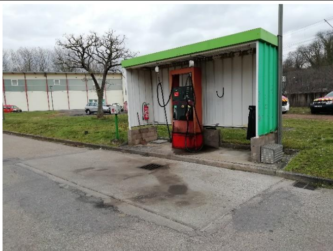
Vue de l'actuelle station de distribution de carburant (gasoil et essence)
