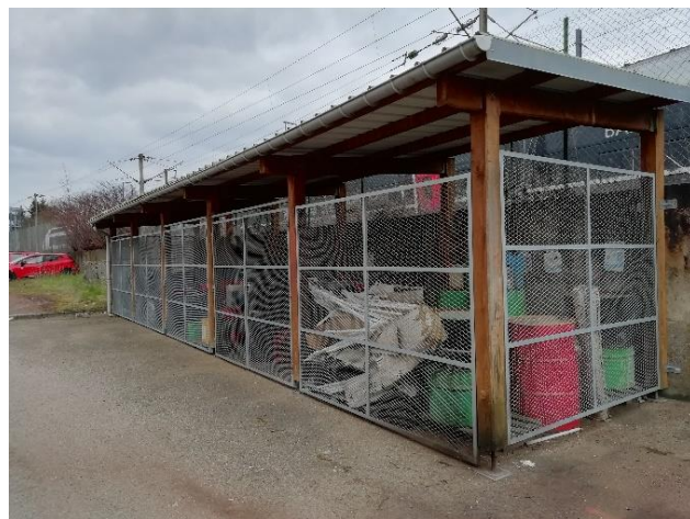
Vue du local de stockage de bidons et fûts de produits dangereux, à l'arrière de l'atelier
