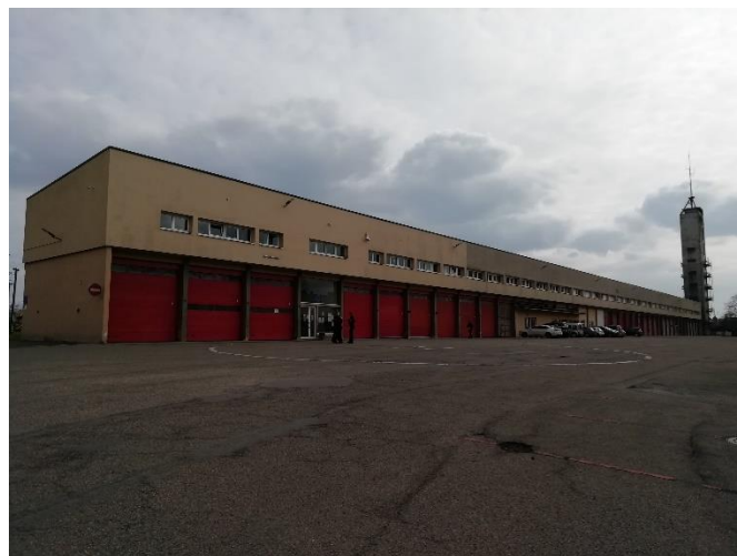
Vue direction sud-est du bâtiment technique 1 et de la tour de séchage
