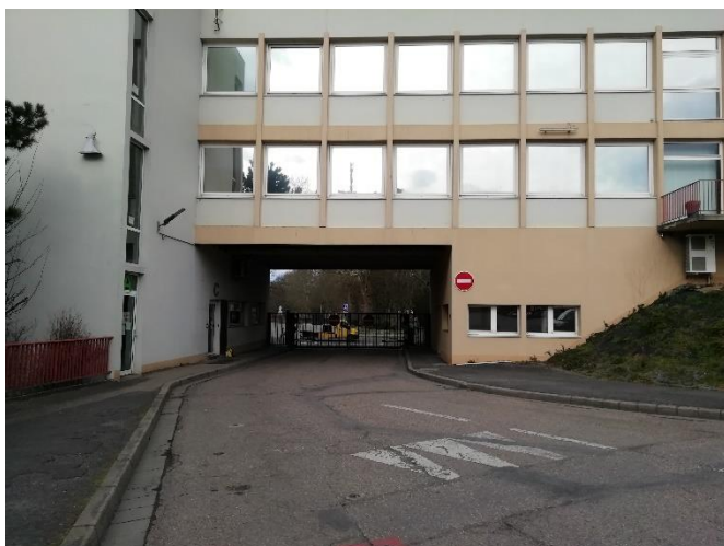
Vue direction nord de l'entrée de la caserne et du bâtiment administratif
