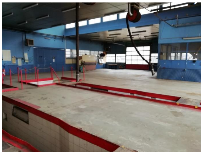
Vue de l'intérieur de l'atelier mécanique et des fosses de visite
