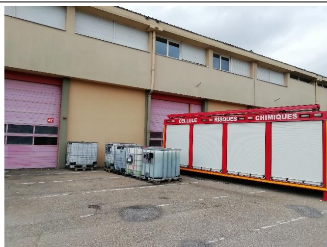
Vue des cubitainers à l'arrière du bâtiment technique 1
