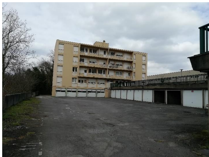
Vue direction nord du bâtiment de logements des officiers et des garages pour résidents
