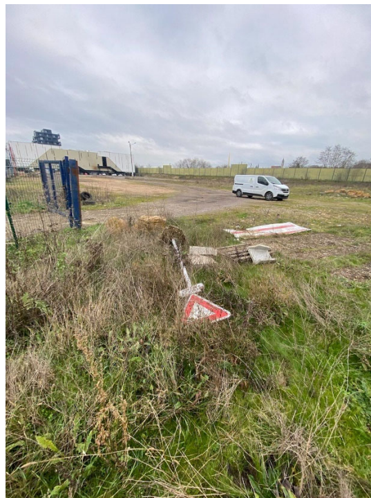
Figure 13 : Panneau et végétation trop dense.
