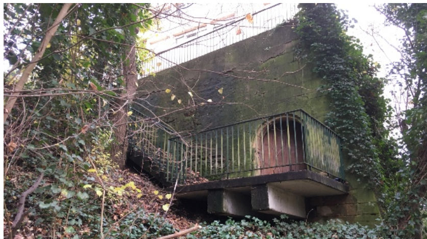
Ancien souterrain militaire au pied de l'immeuble OPH
