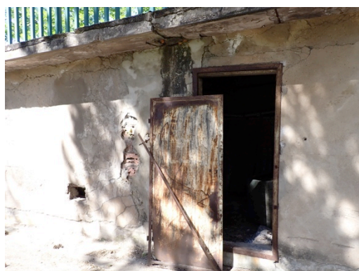
Porte et trou d'accès aux bâtiments semi-souterrains sud-ouest
