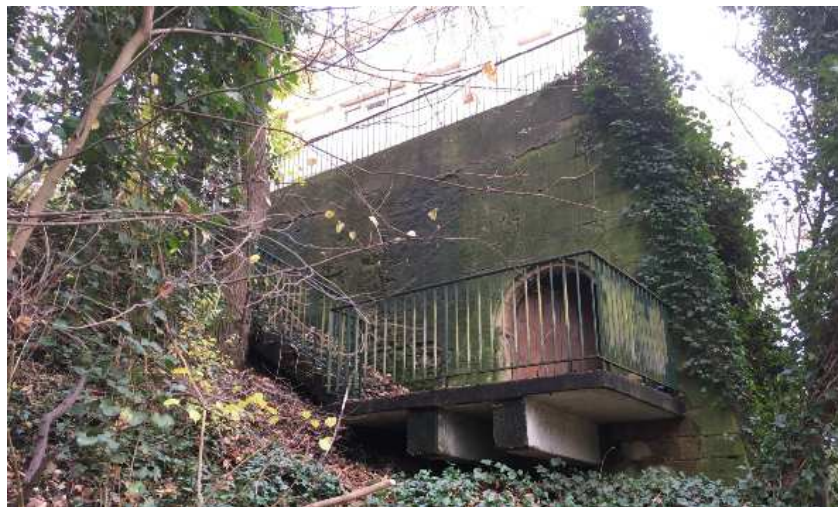
Souterrain militaire au pied de l'immeuble OPH
