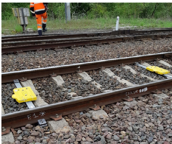
Figure 4 : Exemple de balises ETCS
