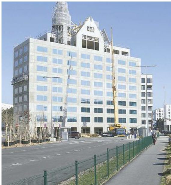
Hôtel de Philippe Starck en chantier
