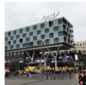
Entrée Nord du MUSE
