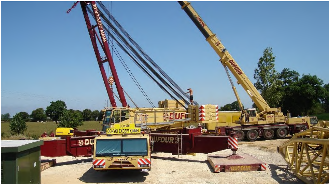
Photo 8. Montage d'une grue de levage
