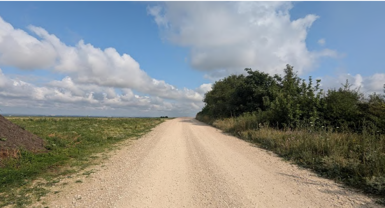
Photo 7. Chemin d'accès élargi et stabilisé
