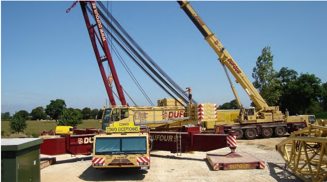
Photo 2. Montage d'une grue de levage
