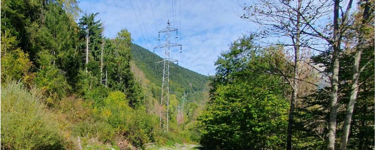
Figure 7 : Piste d'accès à la centrale hydroélectrique et poteau à déposer par rte
