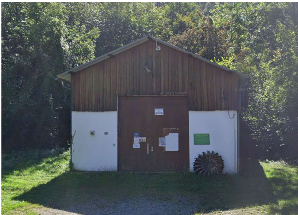
Figure 2 : Exemple de centrale hydroélectrique similaire
