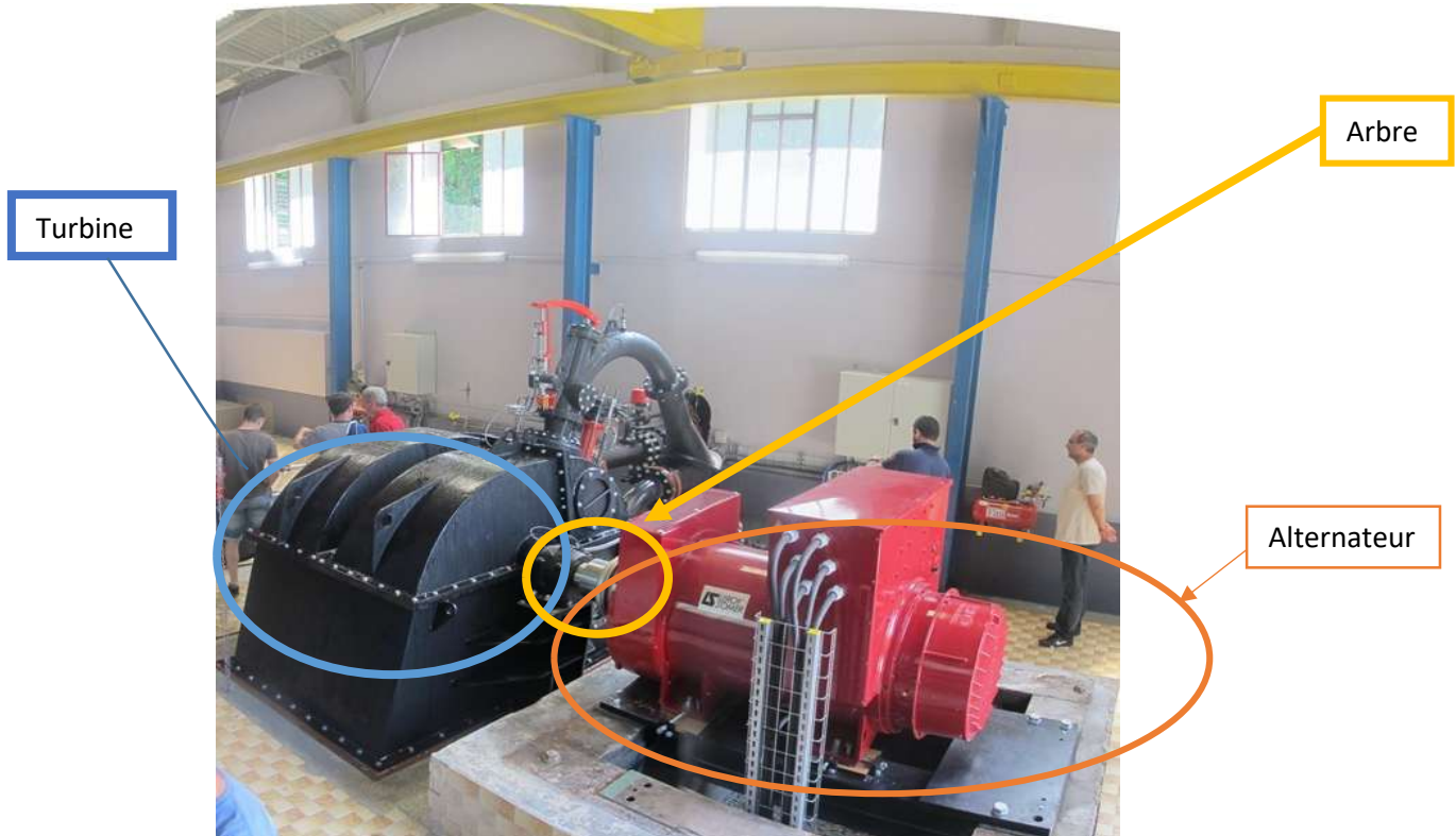
Figure 5. Machine électrogène de la Perrière
