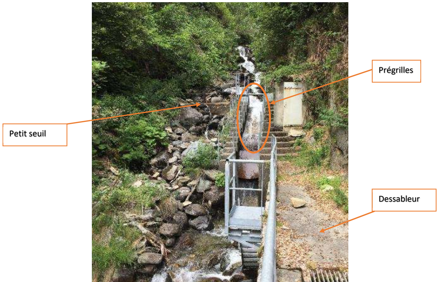
Figure 39. Prise d'eau du Frenet EDF (1) Vue de l'aval vers l'amont
