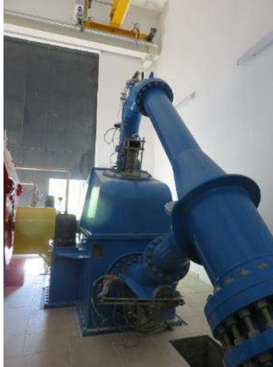
Figure 60. turbine Pelton à axe horizontal
