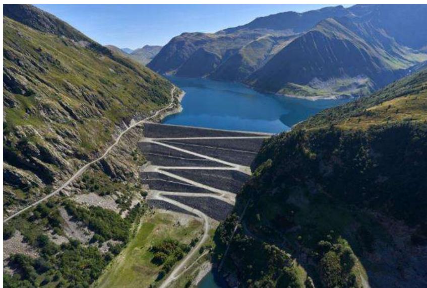
Figure 7.. Barrage de Grand Maison
