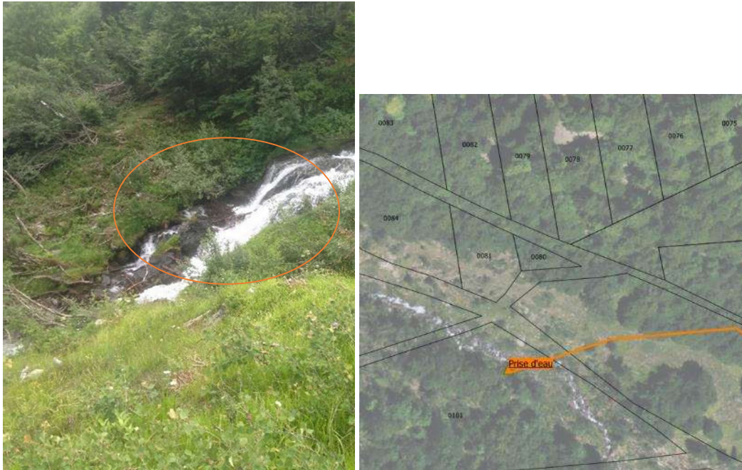
Figure 37.. Photographies de la zone de la prise d'eau
