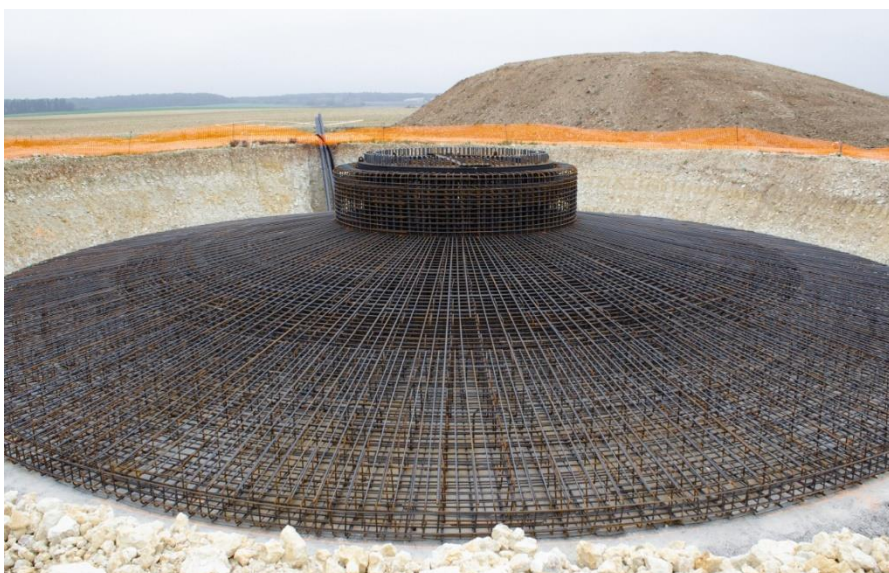
Figure 3 : illustration du ferrailage d'une fondation d'éolienne
