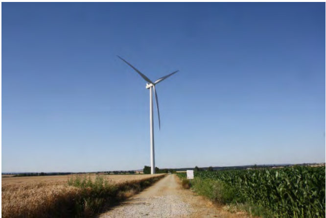
Photo 1 : Exemple de piste d'accès aux éoliennes
