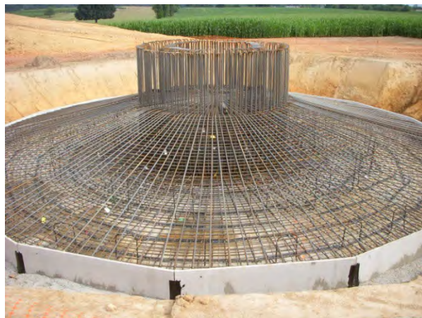
Photo 2 : Construction de l'armature d'une fondation
