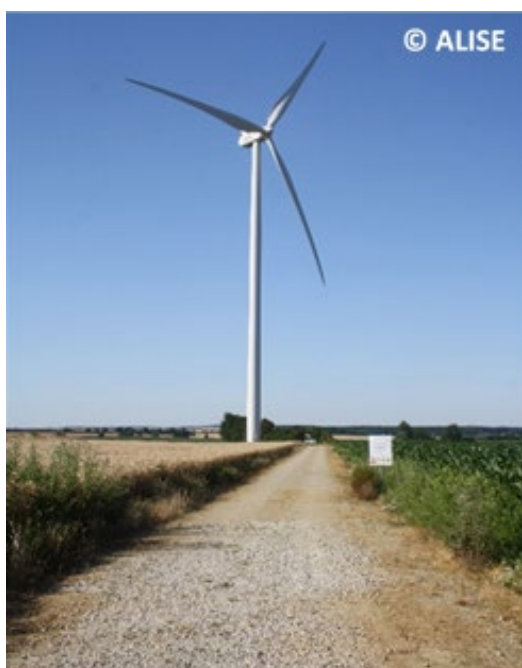
Photo 3 : Exemple de piste d'accès à une éolienne
