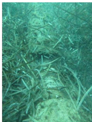
Figure 24 : Décrochage de l'émissaire à 193 m de la côte, dans la Posidonie
