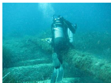
Figure 27 : Emissaire suspendu sur 1 m de haut par endroit à 493 m de la côte
