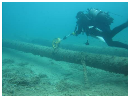
Figure 31 : Emissaire suspendu au-dessus de fonds meubles à 197 m de la côte
