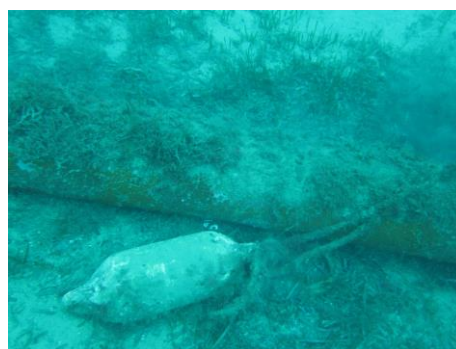
Figure 33 : Bouée de pare-battage prise dans l'émissaire à plus de 900 m de la côte
