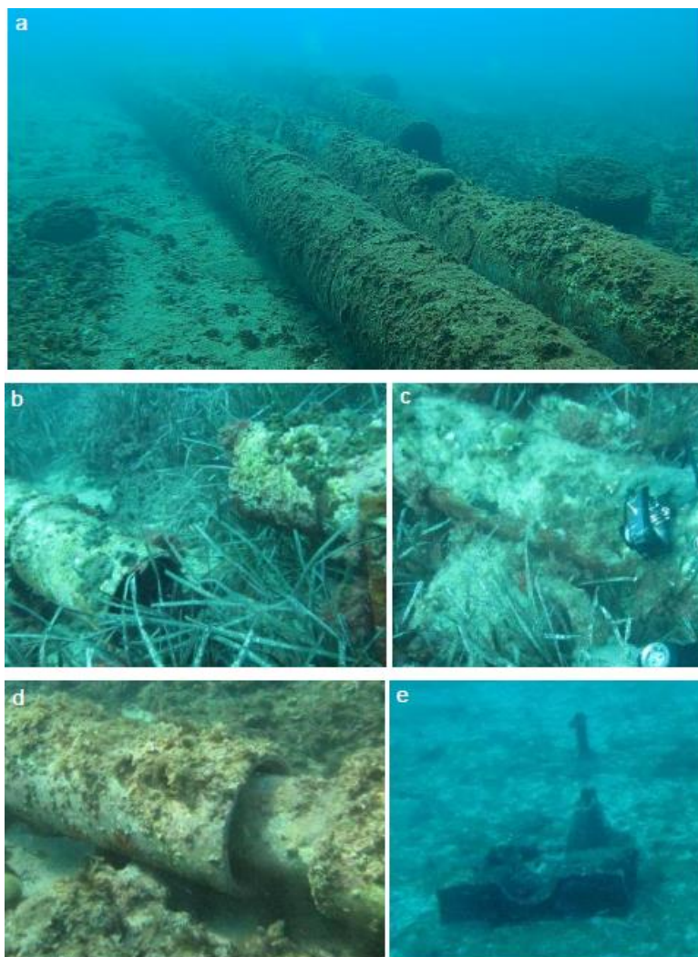
Figure 2 : Exemple de désordre sur l'émissaire Eden Roc : a) anciennes canalisations hors service en parallèle de l'émissaire ; b) rupture de continuité, c) absence de collier ; d) absence de protection ; e) cavaliers en béton sans canalisation
