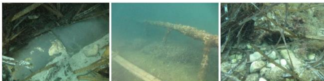
Figure 6 : Photos d'inspection de l'émissaire Renécros
