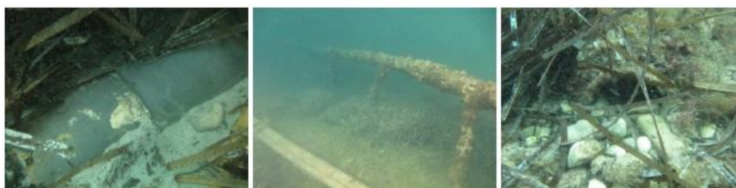
Figure 7 : Photos d'inspection de l'émissaire Renécros
