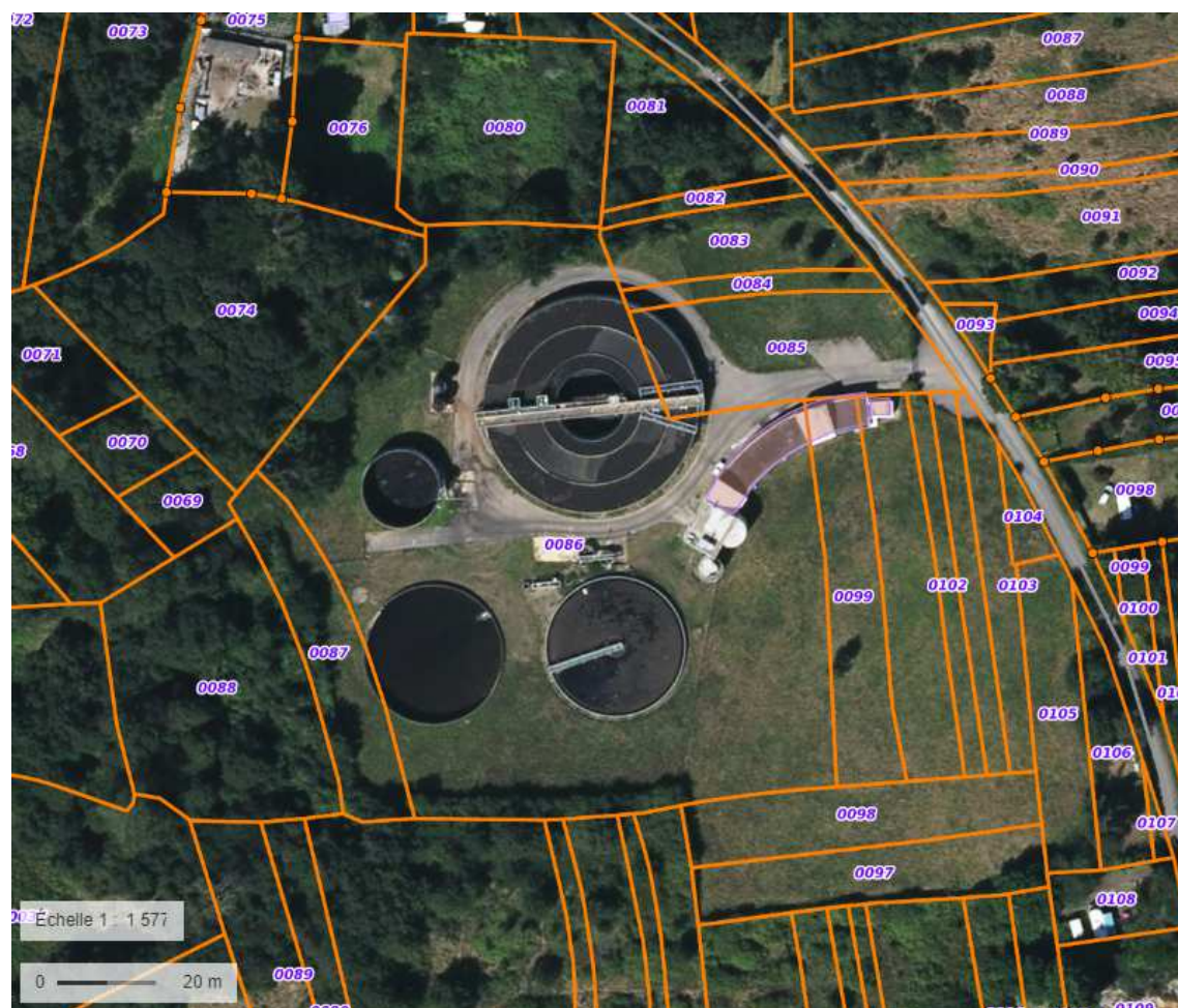
Figure 2 : Vue aérienne de la station d'épuration de Kerners (source Géoportail)
