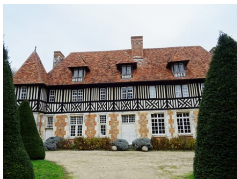
La façade ouest du manoir
