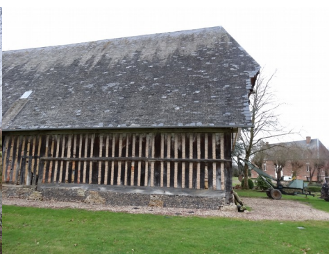
Une vue de la grange avant réfection
