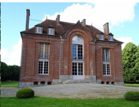
La façade sud
