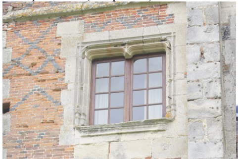
Le détail d'une ancienne baie à meneaux
