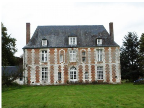
La façade sud (vue proche)
