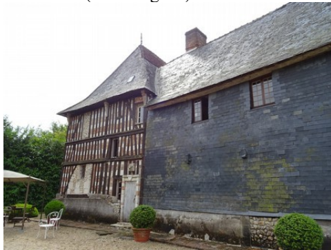
La façade arrière (habillage d'ardoises)
