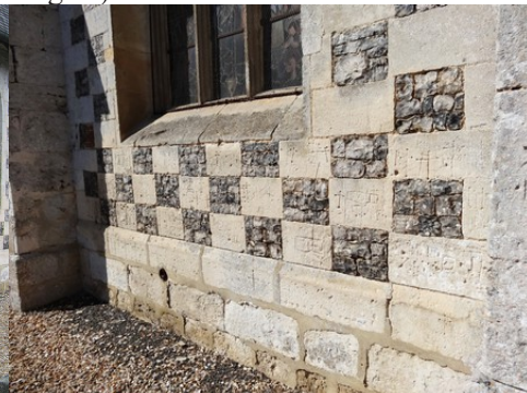
Un appareil en damier pierre-silex
