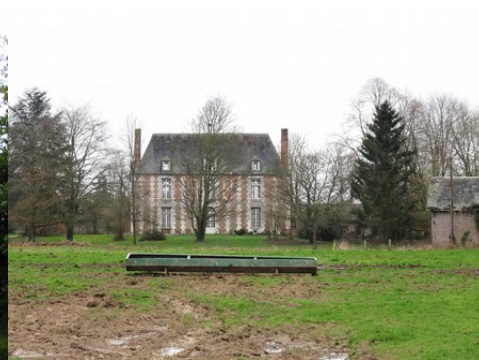
La façade nord (vue éloignée)
