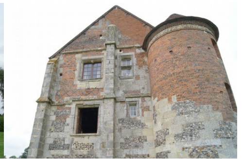
Le pignon est (vue proche)
