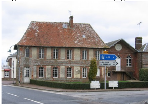
L'emploi de briques, silex et tuiles
