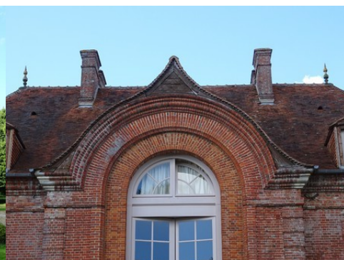
Un détail de l'arcade centrale en briques
