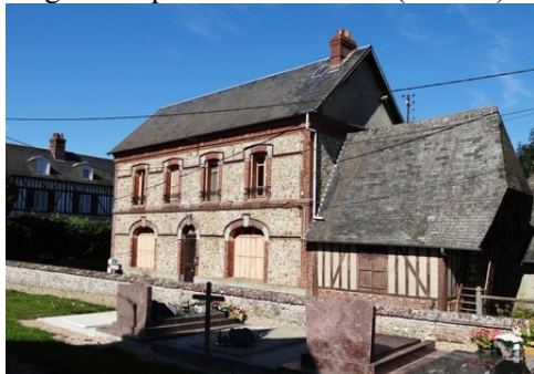
Une maison mêlant moellons, briques
