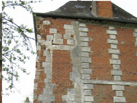
Le pignon est (vue proche)
