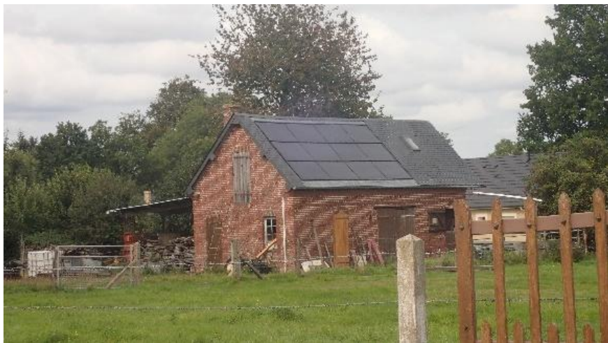
PHOTO 4- EXEMPLES D'INSTALLATIONS DE SOLAIRE PHOTOVOLTAÏQUE SUR DU BATI TRADITIONNEL (HAUT) ET SUR DES LOGEMENTS SOCIAUX (BAS). SOURCE: GAMA ENVIRONNEMENT
