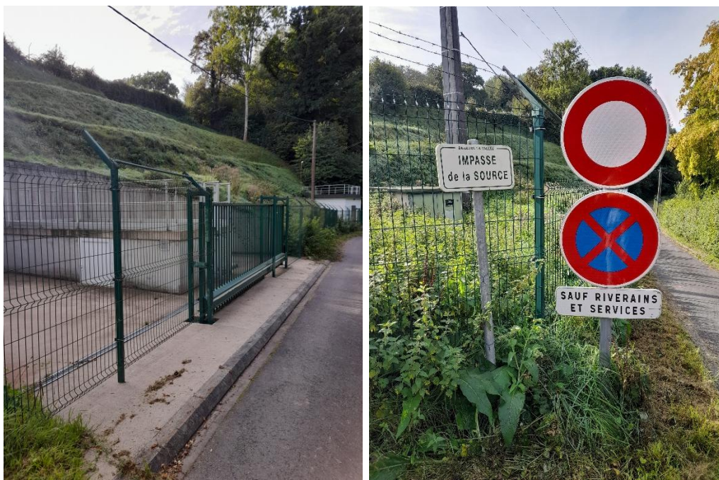
PHOTO 1- CAPTAGE DE BAILLEUL-LA-VALLEE. SOURCE: GAMA ENVIRONNEMENT
