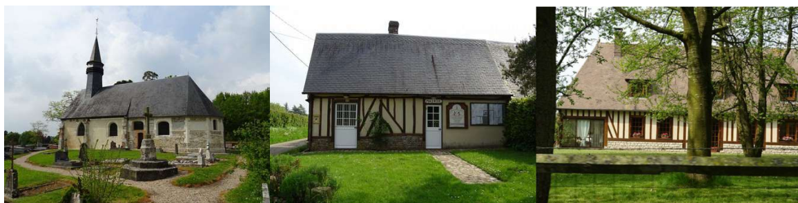
L'église de Barville en Lieuvin / La mairie de Barville en Lieuvin / Un exemple d'architecture rurale
