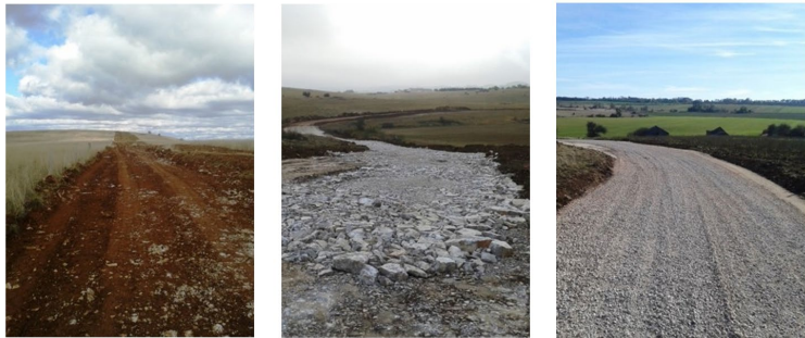
Figure 6 : Opération de décapage ; mise en place de la couche de fond de forme ; mise en place de la couche de finition (source : Q ENERGY France)
