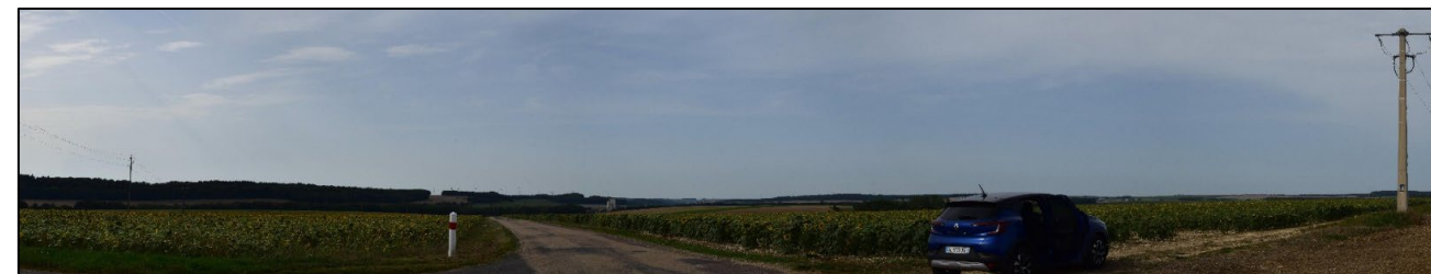
Ouverture sur la zone de projet depuis la RD151 aux abords de la ferme de Courberoies
