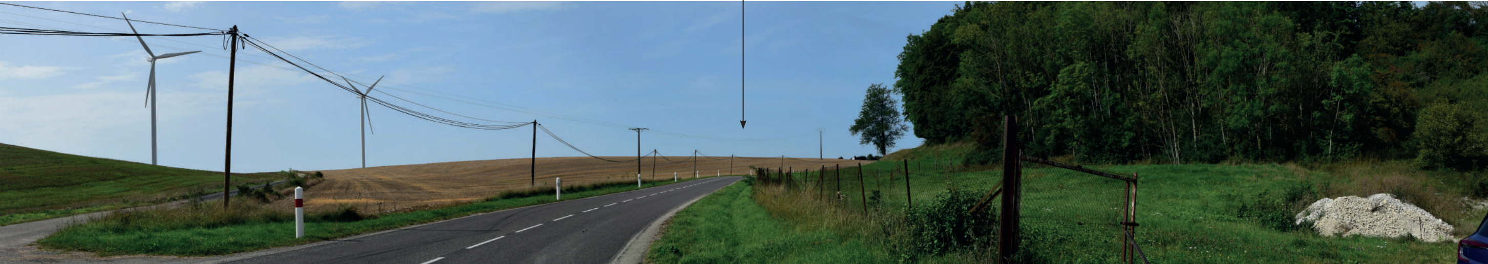
ÉTAT INITIAL (parcs en exploitation)
