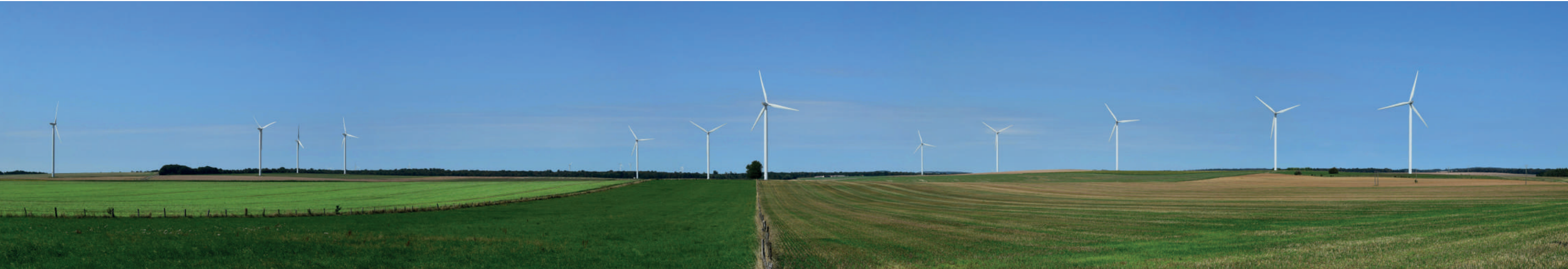
ÉTAT INITIAL (parcs en exploitation)
