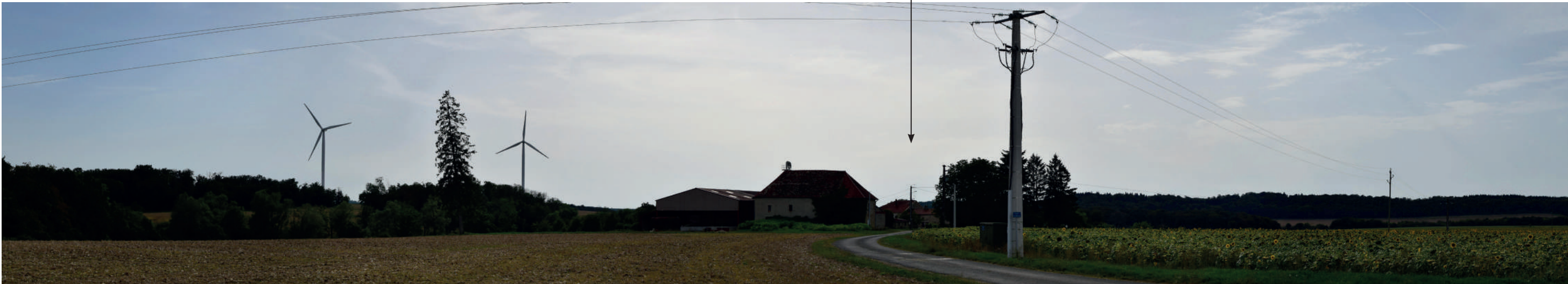
ÉTAT INITIAL (parcs en exploitation)
