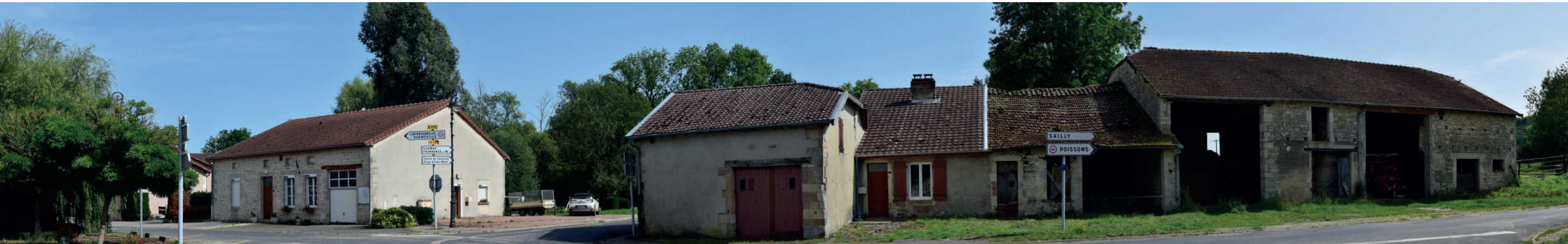
ÉTAT INITIAL (parcs en exploitation)
