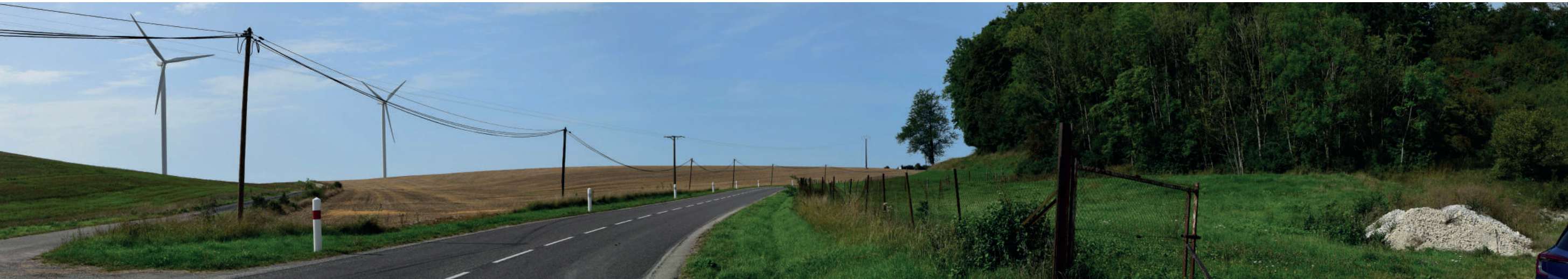
ÉTAT INITIAL (parcs en exploitation)
