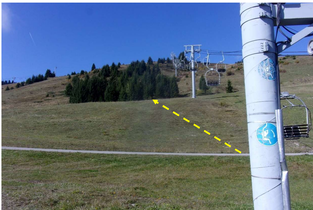
Zone 1 au niveau de l'ancien P2 – nouvel axe TSD
