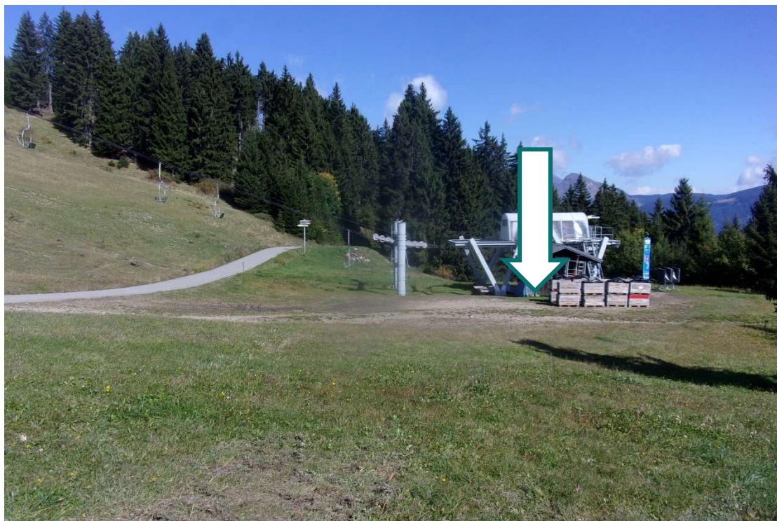
Plate-forme de départ proposée et emplacement gare G1 en lieu et place de la G1 TS Grande Ourse
