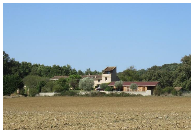
Ancienne ferme rénovée en habitation avec hangar à façades en briques
