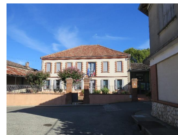
Figure 76. Mairie de Saint-Sardos
