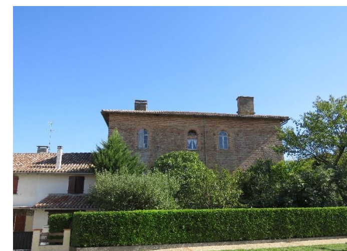
Figure 70. « Maison Renaissance » ou Maison Lasserre de Saint-Sardos Source : photographie SOE – visite de terrain du 05/10/2022
