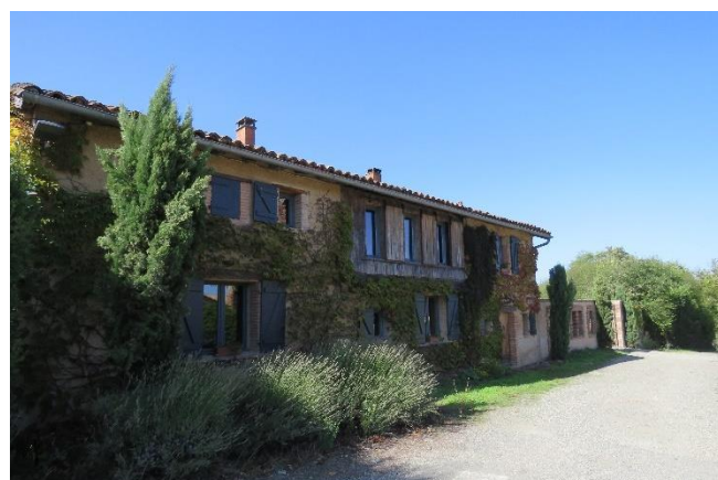
Maison rénovée aux façades en briques, crépi et bois
