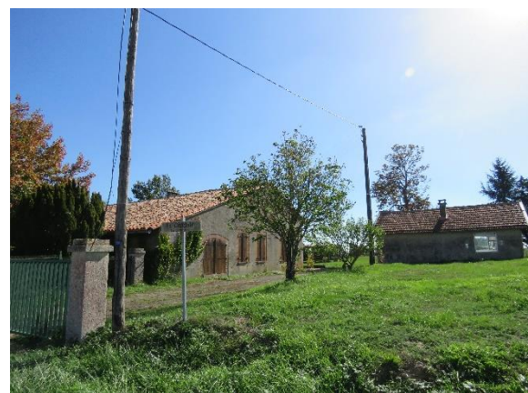
Ancienne ferme rénovée en habitation avec annexe
