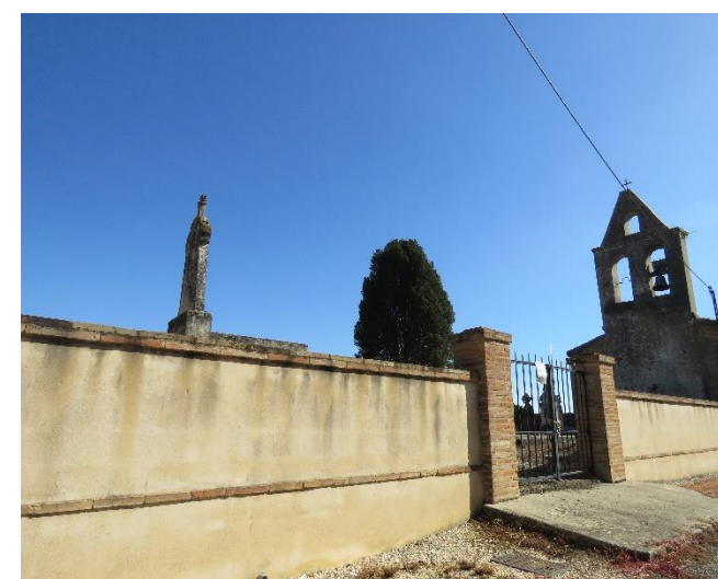
Figure 71. Cimetière et chapelle de Brivecastel sur la commune de Comberouger
