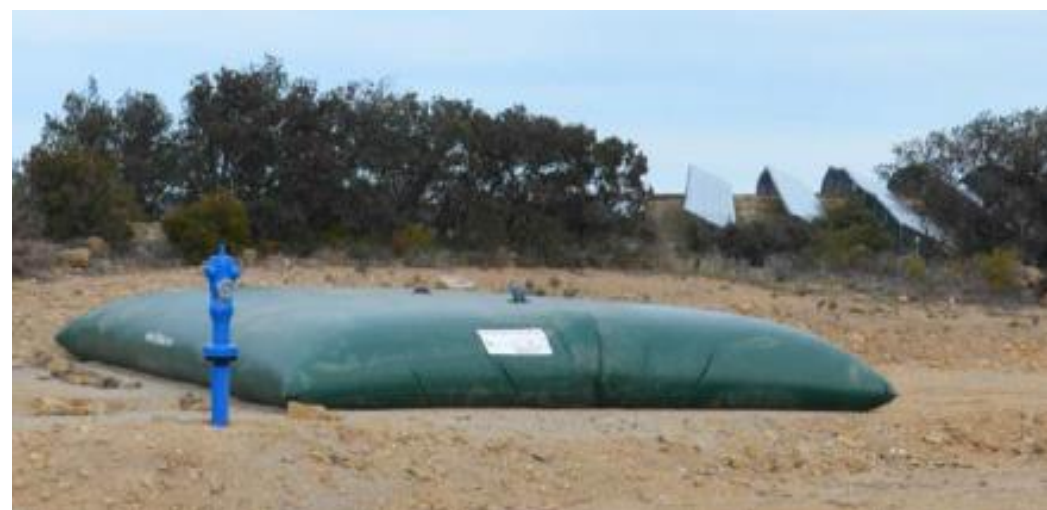
Figure 21 : Bâche à eau
