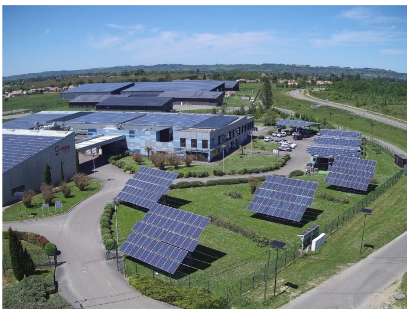
Figure 6 : Siège du groupe REDEN - Roquefort (47) (Source : REDEN)
