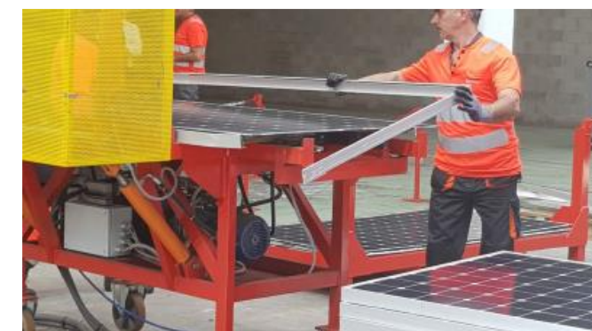
Figure 10 : Décadrage des modules
