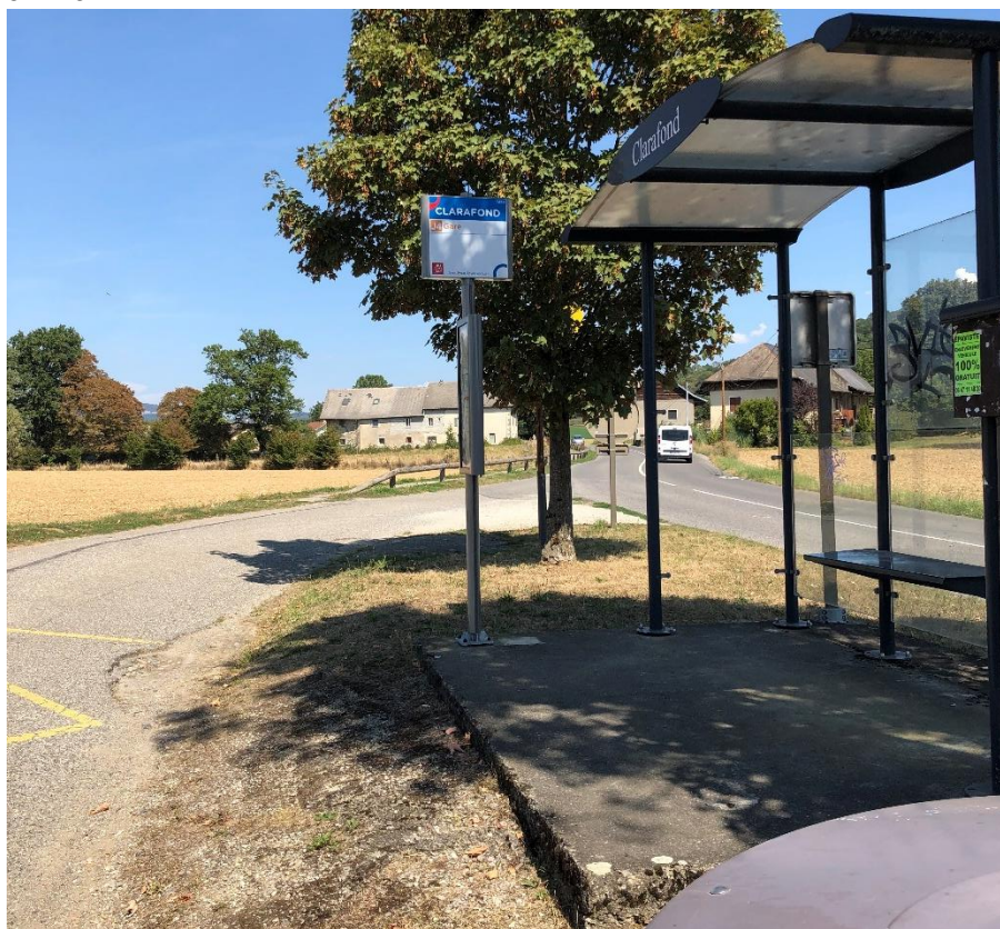
Figure 13 – Clarafond (Sales), exemple d'arrêt non conforme
