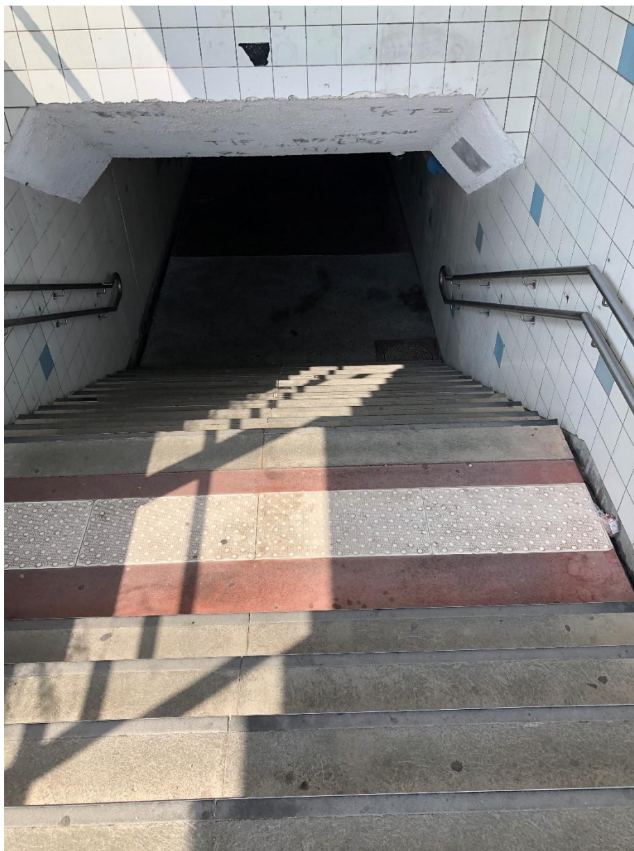
Figure 9 – Passage souterrain non conforme sous la voie ferrée au niveau de la gare de Rumilly
