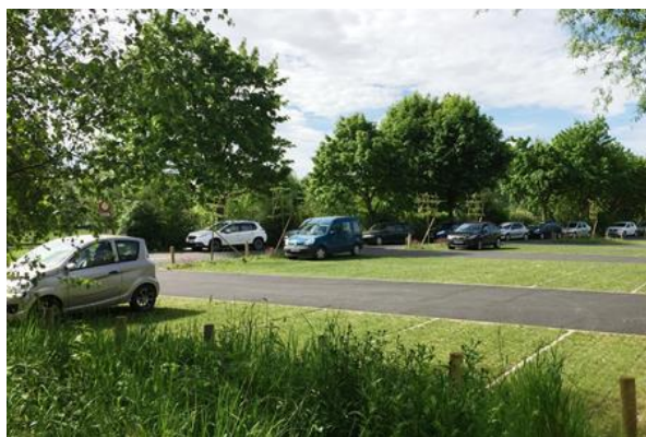
Parking perméable et végétalisé
