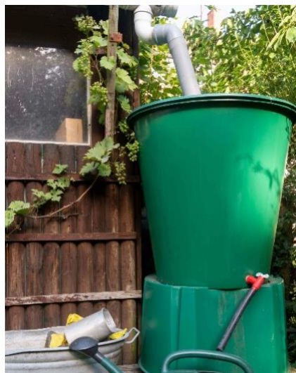
Récupérateur d'eau de pluie
