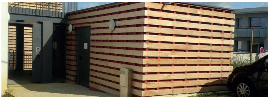
Exemple de point de regroupement extérieur couvert
